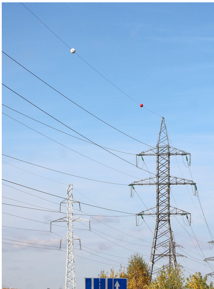
Рисунок 88 Опора линии электропередач. В самом верху натянут грозозащитный трос, который работает молниеприемником. Для безопасности пилотов на тросе закреплены яркие пластиковые сферы, так линии электропередач гораздо заметнее с высоты.
